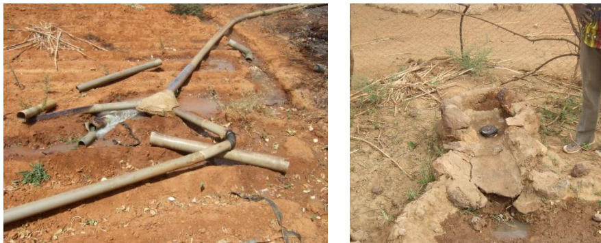
Figure 2: Tuyaux de refoulement/distribution & bassin d'irrigation
