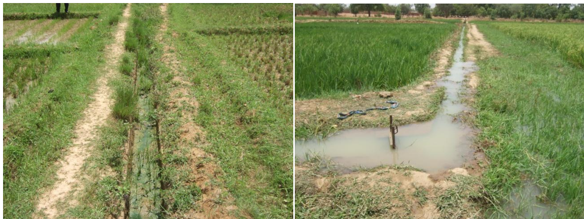
Figure 5: Canal secondaire enherbé et envasé / engorgement du canal secondaire
